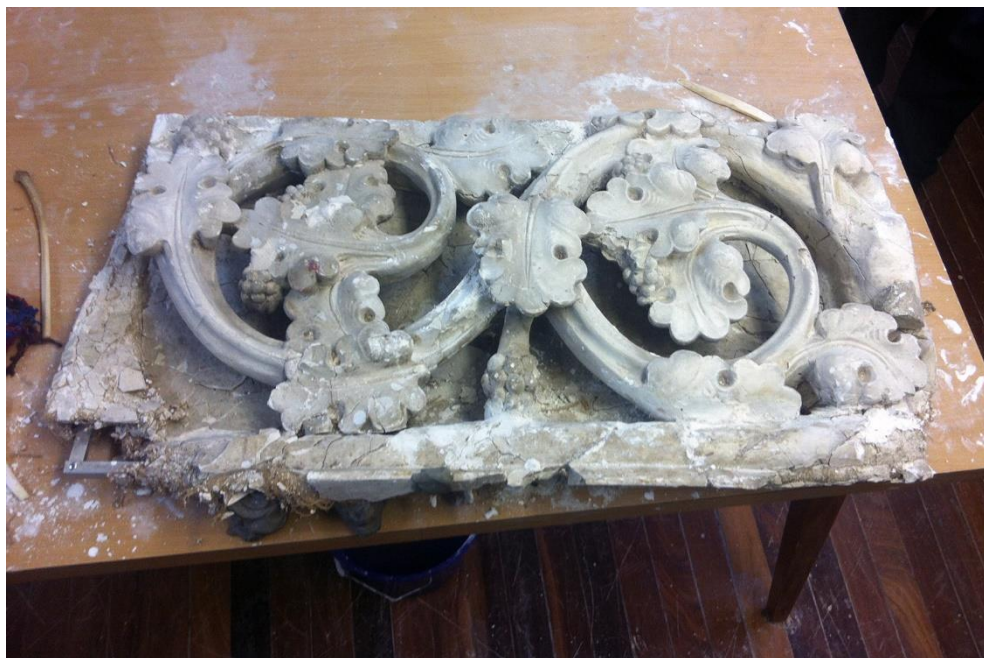
Fig. 1 - Moldura con follaje en estado extremo de deterioro. La pieza había sido «restaurada» con anterioridad, sustituyendo el marco original de madera por uno de aluminio. Foto: E. Hidalgo.
