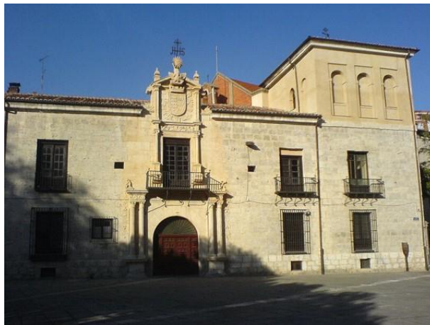
Fig. 2 - Fachada de la Casa del Sol o palacio de Gondomar en Valladolid, una de las sedes del Museo Nacional de Escultura.
